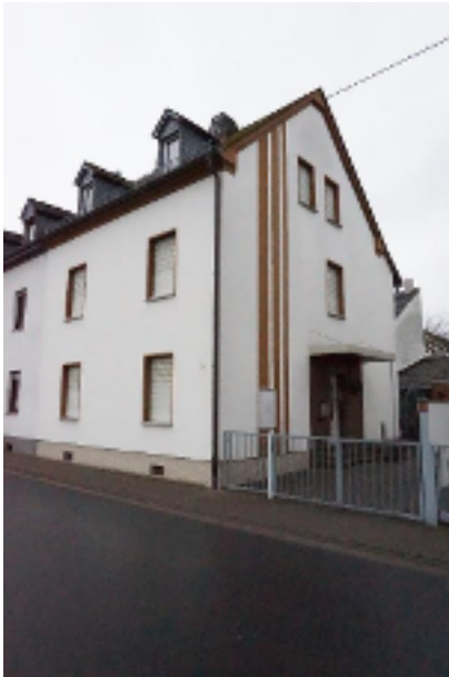
Gesamtansicht von rechts
